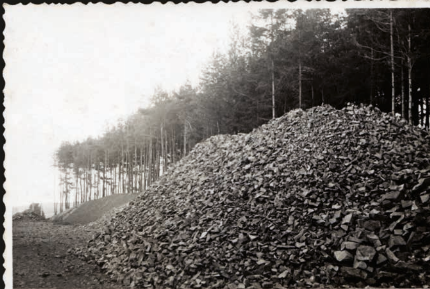
RUČNĚ DOBÝVANÝ KÁMEN NA STAVBU SILNICE
