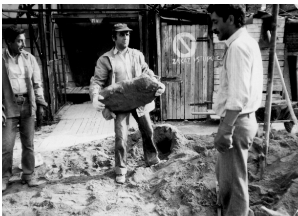
Výkopové práce, 80. léta, Brno | Soukromá sbírka pamětníka
