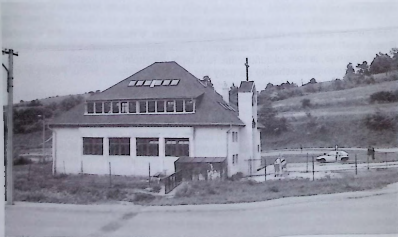
„Pastorační centrum“ po přestavbě.
